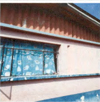
Foto 9: Modulo B vista lateral de cubierta de asbesto.
