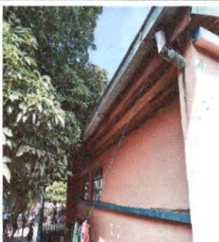
Foto 9: Modulo B vista lateral de cubierta de asbesto.
