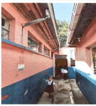
Foto 7: .Modulo A vista pasillo lamina de asbesto cemento con cielo falso de madera en malas condiciones
